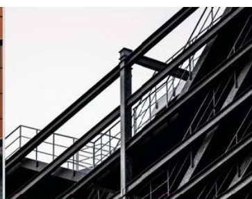
ESTRUCTURAS DE ACERO
