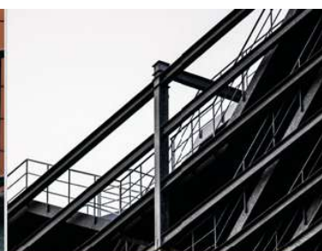
ESTRUCTURAS DE ACERO
